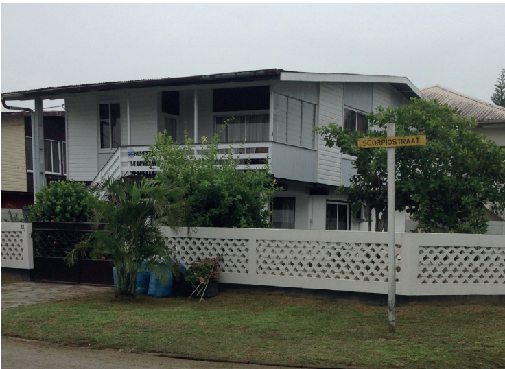
55 Toevoeging van louvres aan de windzijde van het balkon
