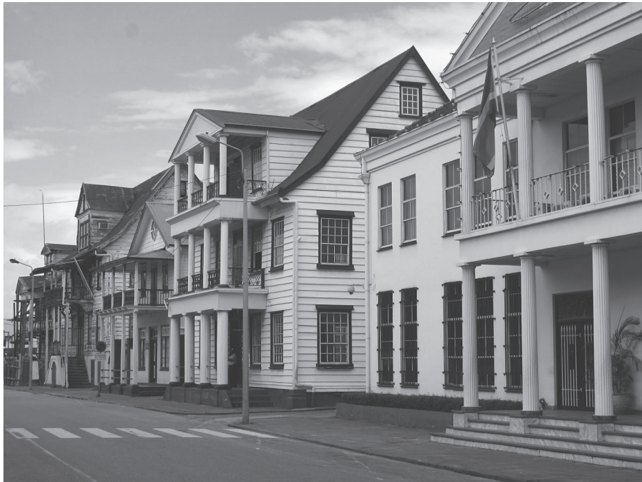
8 Koloniale binnenstad van Paramaribo
