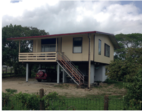
54 Vervanging van de houten gevel door vezelcementplaten
