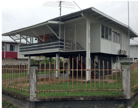
50 Luifels aan het dak ter hoogte van het balkon
